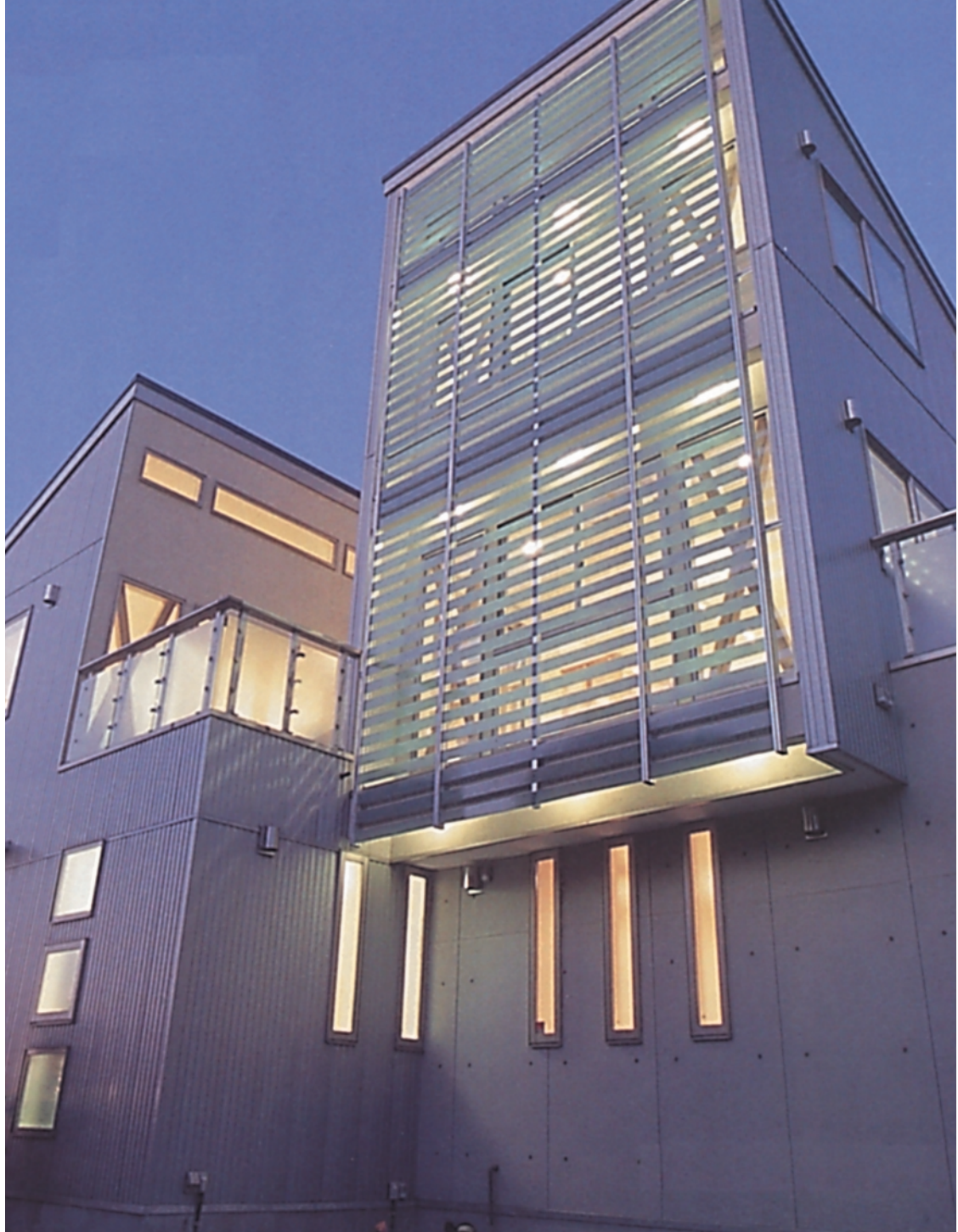
1階の縦の窓の明かりとFRPルーバー越しの横の明かりがリズムカルな外観をつくっている
