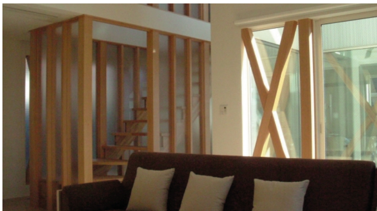
筋交い部分の窓と階段室のポリカーボネートの壁により外の光を取り入れている
