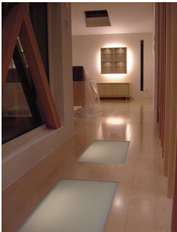
リビングへ続く床にガラスを入れ、暗くなりがちな1階に光を通して
